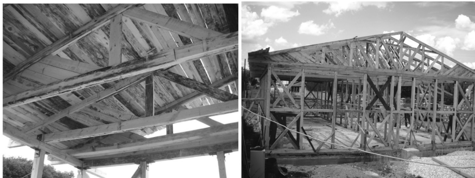
Slika 3. Rešetkasta krovna i skeletna konstrukcija u fazi izgradnje prije zatvaranja
