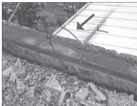
Slika 7. Neadekvatno ankeriranje
