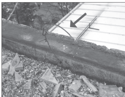
Slika 5. Vezivanje vijenca krova armaturom
