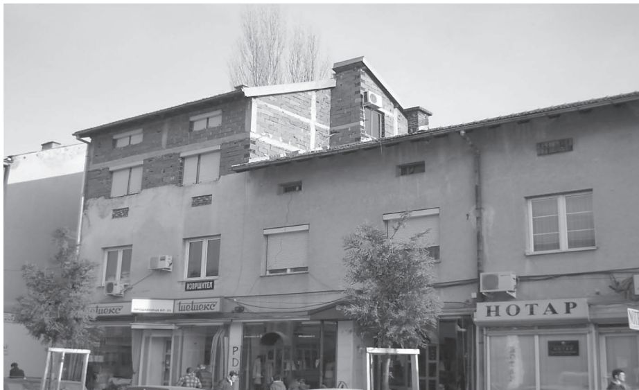
Slika 1. Promjena visine postojećeg objekta nadgradnjom od dva nova kata
