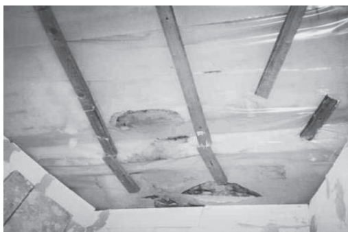
Slika 2. Razvoj gljivica i plijesni zbog kondenzacije vodene pare unutar krovišta
